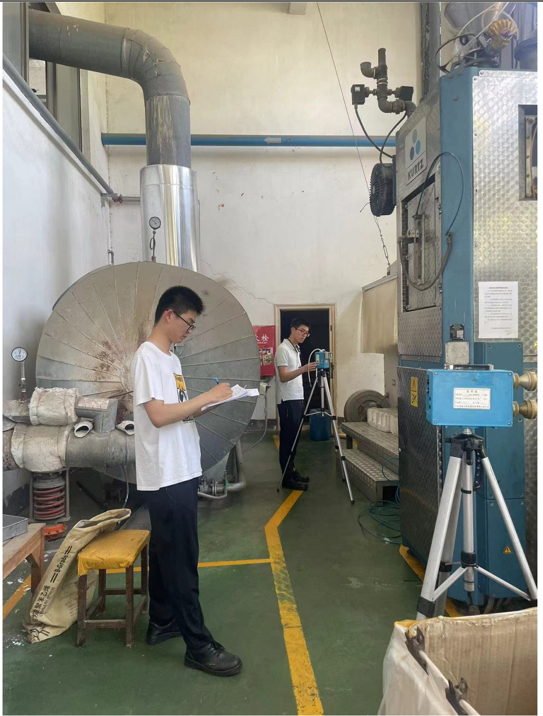
现场调查、 现场采样、 现场检测图 像影像
